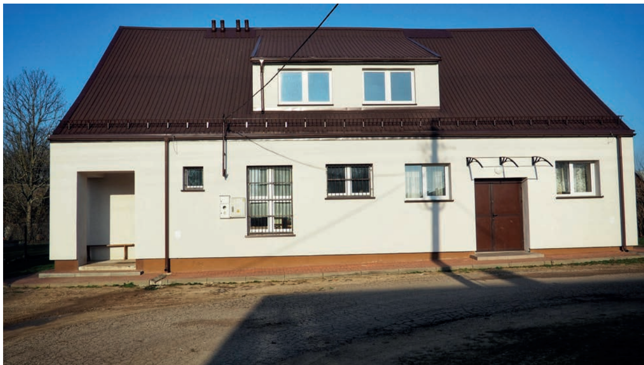
Świetlica w Barankach
